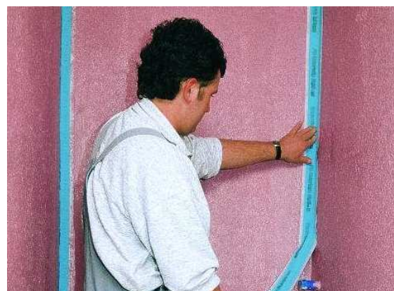
PCI Pecitape накладывается на свеженанесённый слой герметика.
