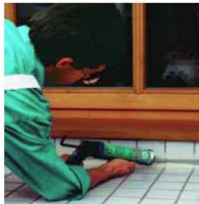
Эластичная герметизация углов и соединительных швов на плиточном покрытии рабочей поверхности на кухне.
