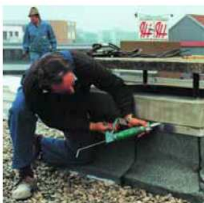
Эластичная герметизация соединительных швов вытяжной трубы между бетоном и фартуком из нержавеющей стали.
