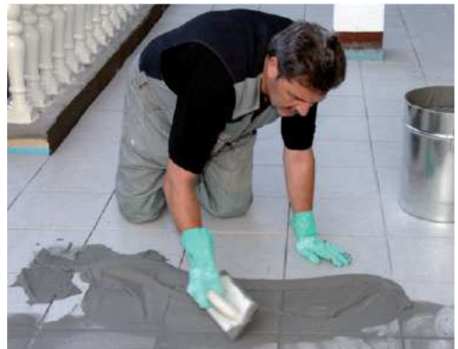
PCI Rapidfug удобен для легкой и быстро схватывающейся заделке швов на глазурованной плитке и керамограните.
