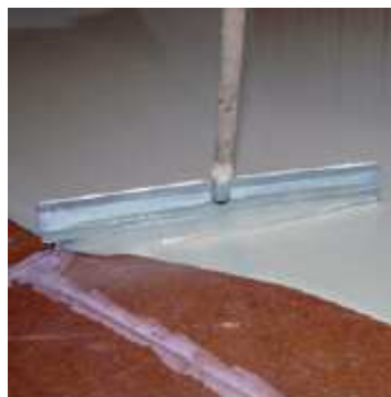
с помощью соответствующей ракли сформировать слой необходимой толщины...
