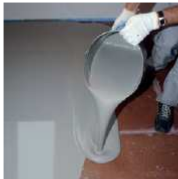
Вылить PCI® Nanosilent на основание ...
