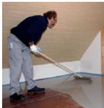
и удалить пузырьки воздуха с помощью игольчатого валика.
