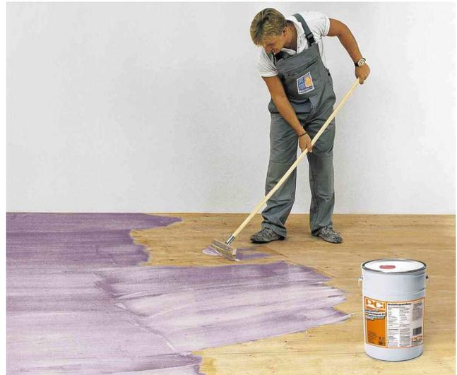
PCI Gisogrund 404 фиолетового цвета для контроля грунтовки обеспечивает высокую прочность сцепления выравнивающих смесей и покрытий к соответствующему основанию.
